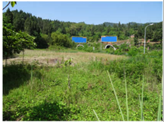
施工场地恢复
