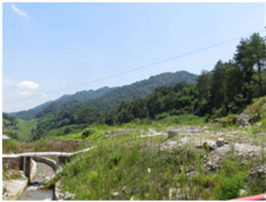
施工场地恢复
