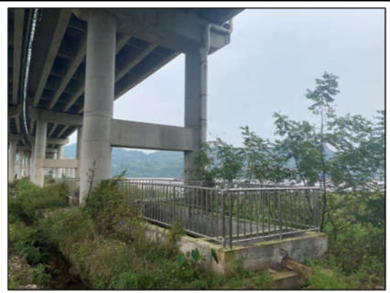
渠江特大桥沉淀隔油池
