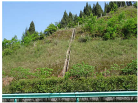
边坡绿化工程
