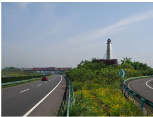
高速公路沿线绿化工程
