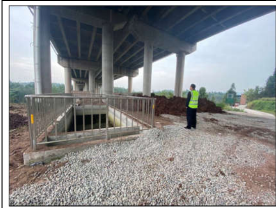
流江河大桥沉淀隔油池
