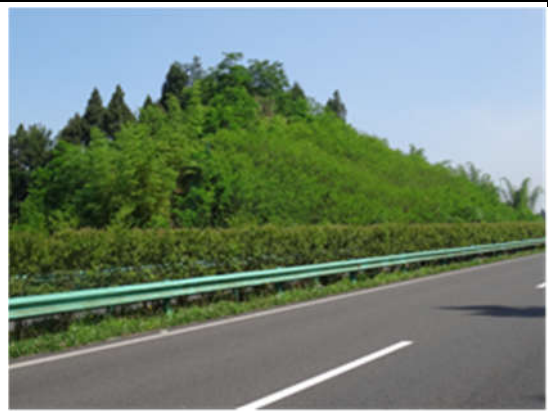
高速公路沿线绿化工程
