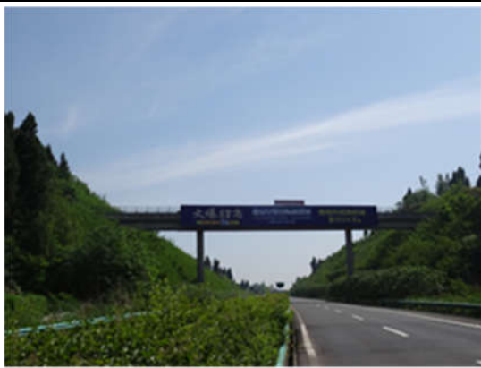
高速公路沿线绿化工程
