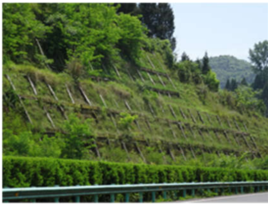
边坡绿化工程
